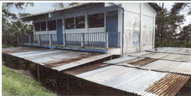
Foto1: Sustitución de lamina por lamina Troqueladfa Aluzinc. Calibre 26 exacto son 124 m 2
