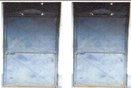
Foto 3: Mantenimiento a estructura ( lijado, cepillado, sujeciones y aplicación de pintura), en 3 puertas de metal de 1 metro de ancho por 2.70 metros de alto
