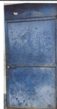
Foto 4: Mantenimiento a estructura ( lijado, cepillado, sujeciones y aplicación de pintura), en 3 puertas de metal
