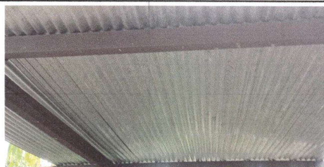
Foto 2: Sustitución de estructura de soporte metal por metal 124 M 2
